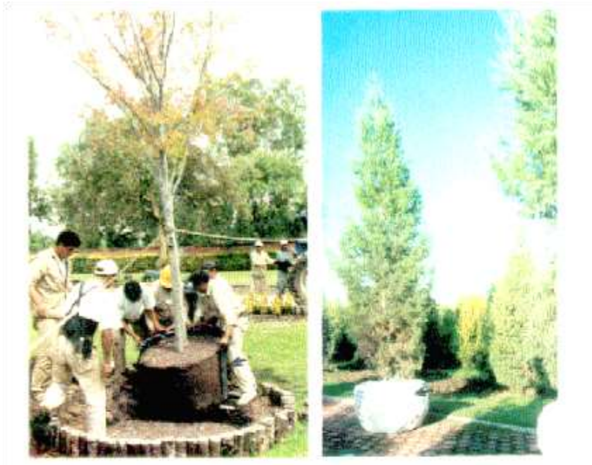
Cepellón de árbol a trasplantar, envuelto en geotextil.
